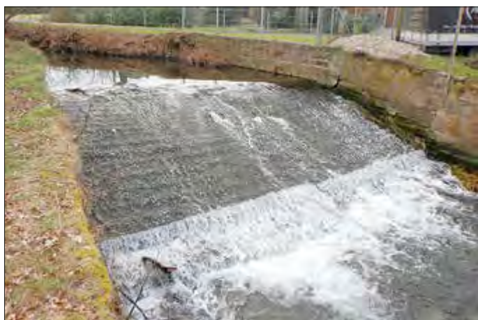
Hier ist nicht nur für Fische Endstation. Es ist eines von vielen Querbauwerken in unseren Gewässern, Foto: Göhler, Landratsamt Mittelsachsen
