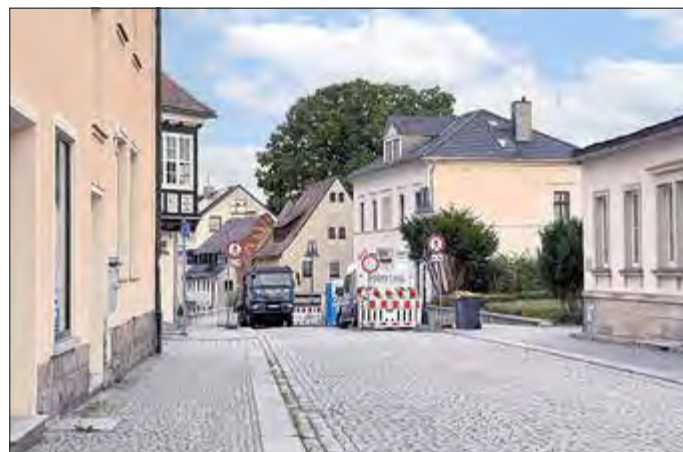
Baustelle auf der Dresdner Straße
